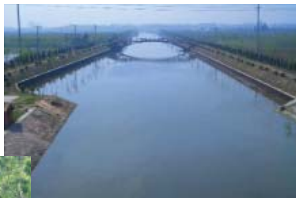
基金が役立てられた工場周辺河川の護岸工事
